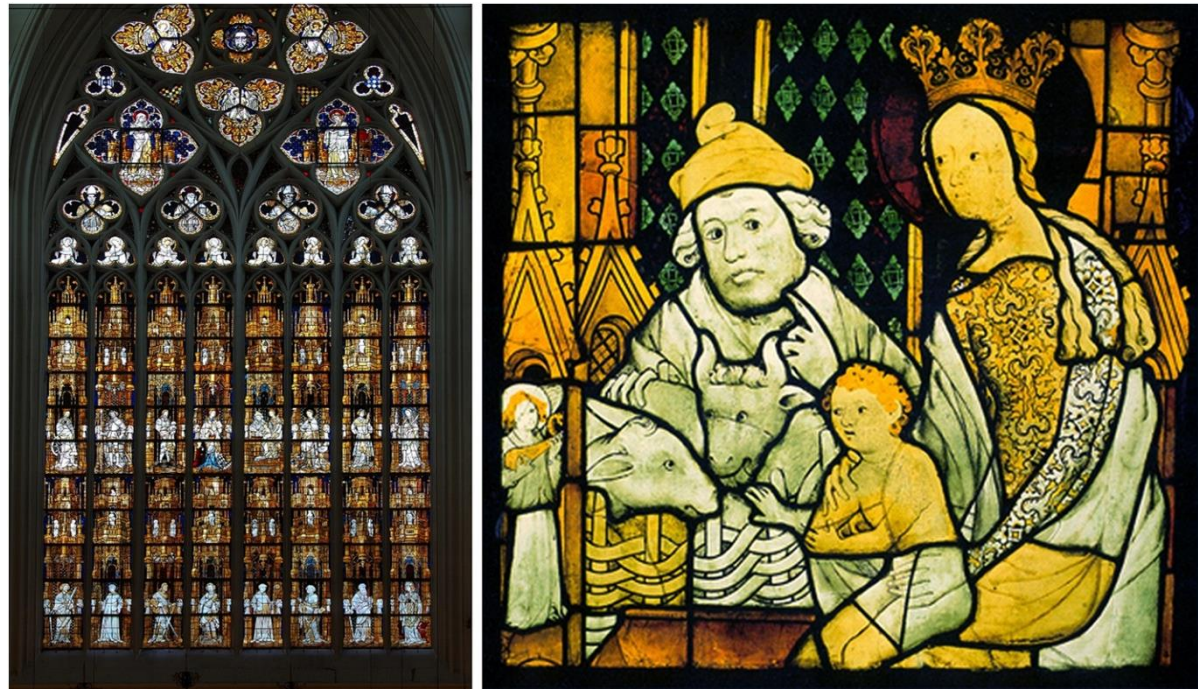
Fig. 14. Alemania, Altenberg, Catedral. Vidriera Oeste después de la restauración de 1999 (izquierda). Fotos: Arnoldius, Wikimedia Commons (izquierda); Glasmalerei Peters, Paderborn (derecha). Detalle de uno de los paneles de esta vidriera, antes de su restauración, donde se aprecia claramente el intenso amarillado de las resinas epoxi aplicadas entre el vidrio histórico y el vidrio de doblaje, según el método Jacobi (derecha)
